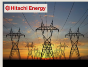
Site 2 : Distribution d'électricité
