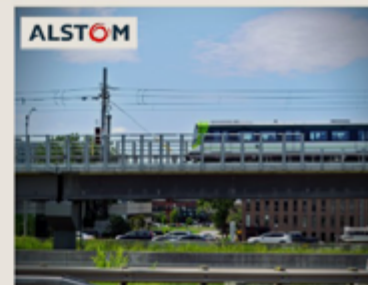
Site 3 : Transports publics électriques
